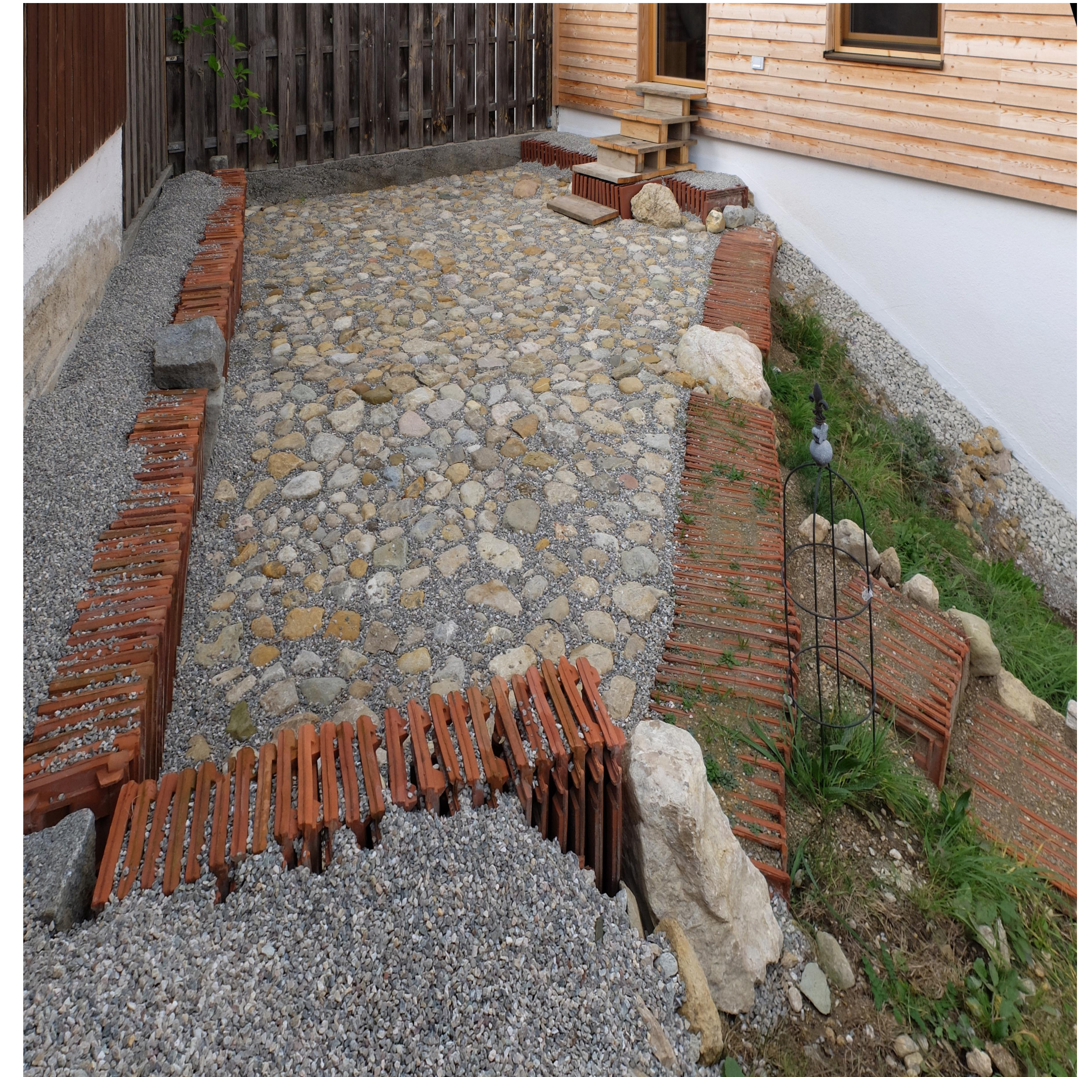
Dachziegel als Stufen und Sitzbänke (noch im Bau) Terrassenbeläge
